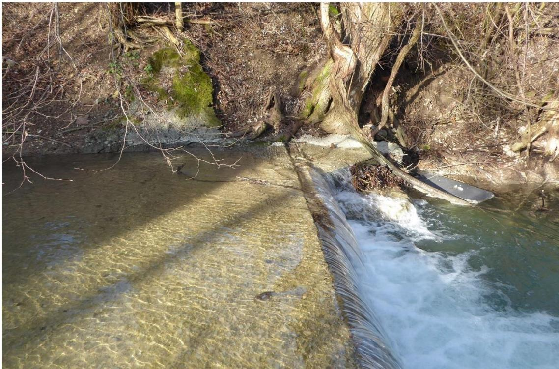
**Abbildung 4: Detail des Absturzes mit betonierter Sohle oberstrom.**
