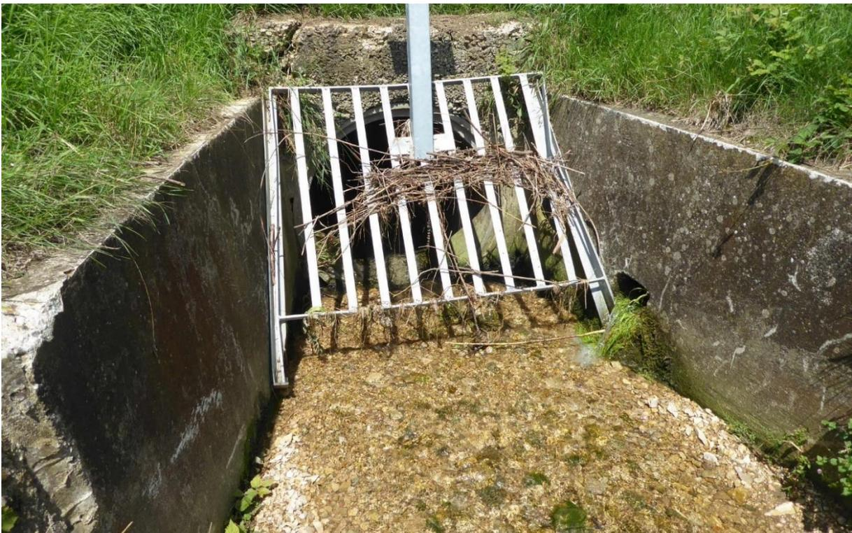
**Abbildung 6:** Der Einlauf in die Verdolung am Projektbeginn. Rechts münden zwei Einleitungen ein.
