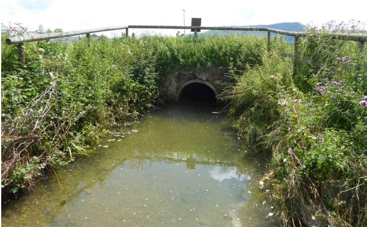
**Abbildung 4: Das Ende der Verdolung am unteren Abschnitt des Projektgebiets. Ein geschotterter Weg führt über den Durchlass (Blick gegen die Fließrichtung).**
