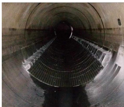
Abb. 6: Abwasserwärmetauscher im Kanal (Quelle: Fa. Uhrig)
